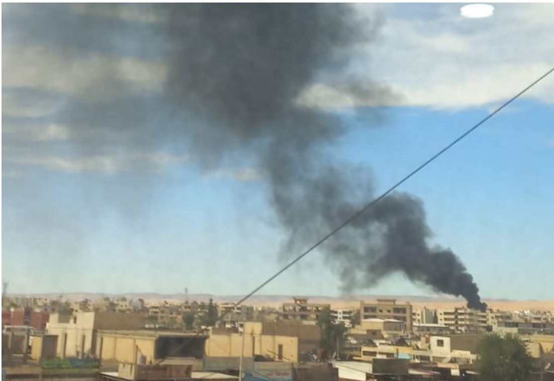
Rechts: durch Beschuss in Brand geschossener Stromverteiler in Qamishlo © Michael Wilk
