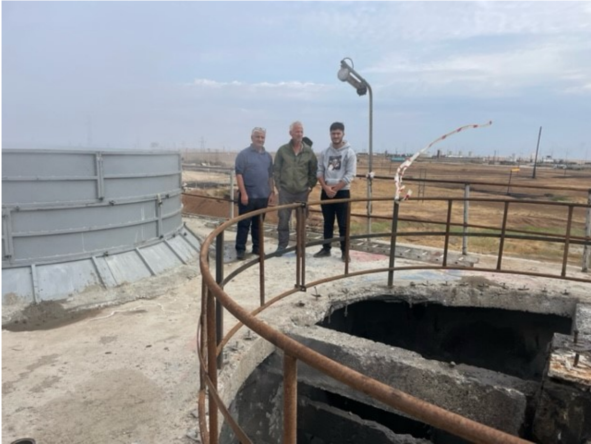
In Stand gesetzter Kühlturm der Raffinerie in Rimelan © Michael Wilk
